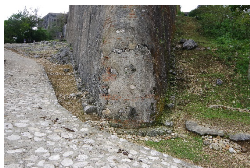
Figure 11: Contreforts de la batterie Coidavid
