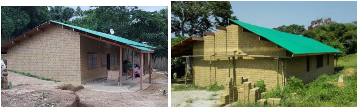
Photos 7 et 8 : Vue de deux logements au quartier général du parc
