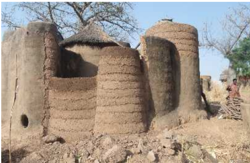
Takienta en reconstruction (Bassamba)/ ©photo CNPC/ janvier 2019
