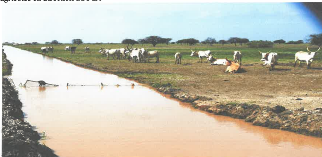
Figure 3: le canal de récupération des eaux de drainage et de lutte contre la divagation du bétail (© P. Triplet)
