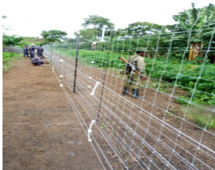
Figure 4 : Démarcation type avec la clôture électrique
